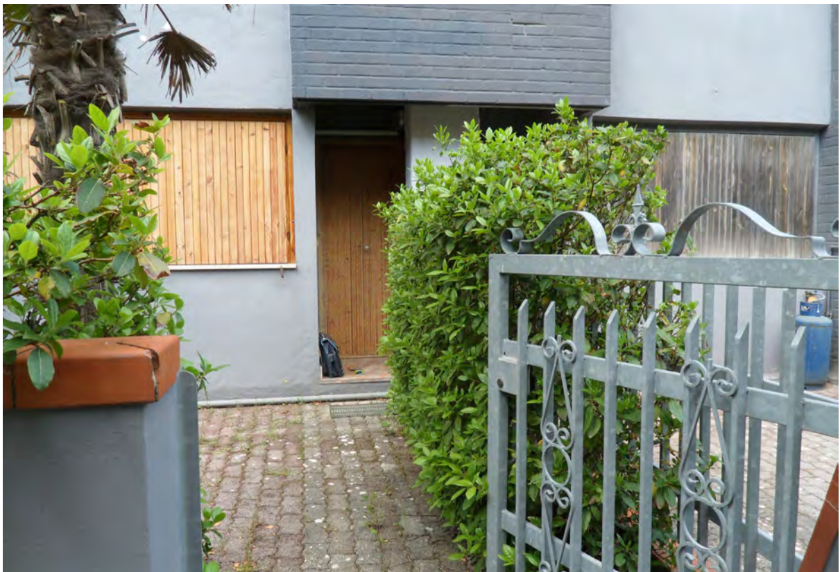
Ingresso alla villetta
